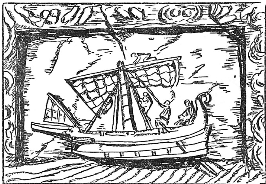
15. Figura: Nave greca
